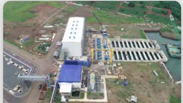
Kolam Pengambilan Air Laut Intake Pond
