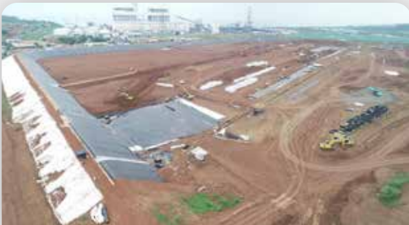
Tempat Penimbunan FABA (Abu Terbang dan Abu Dasar) Solid Waste Disposal (FABA)
