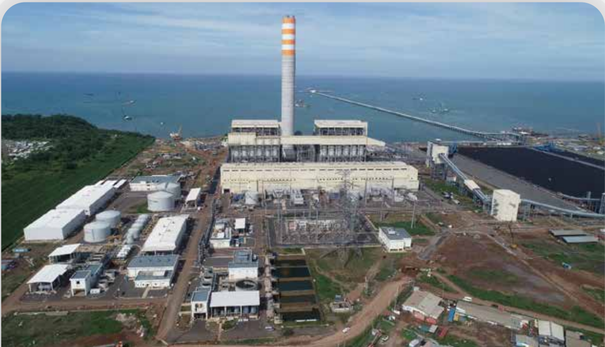
Tampak Keseluruhan Proyek Project Overview
